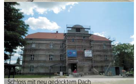
Schloss mit neu gedecktem Dach
